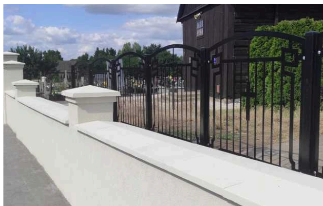
Ogrodzenie zabytkowego kościoła w Parzęczewie — praca pod nadzorem konserwatora zabytków
